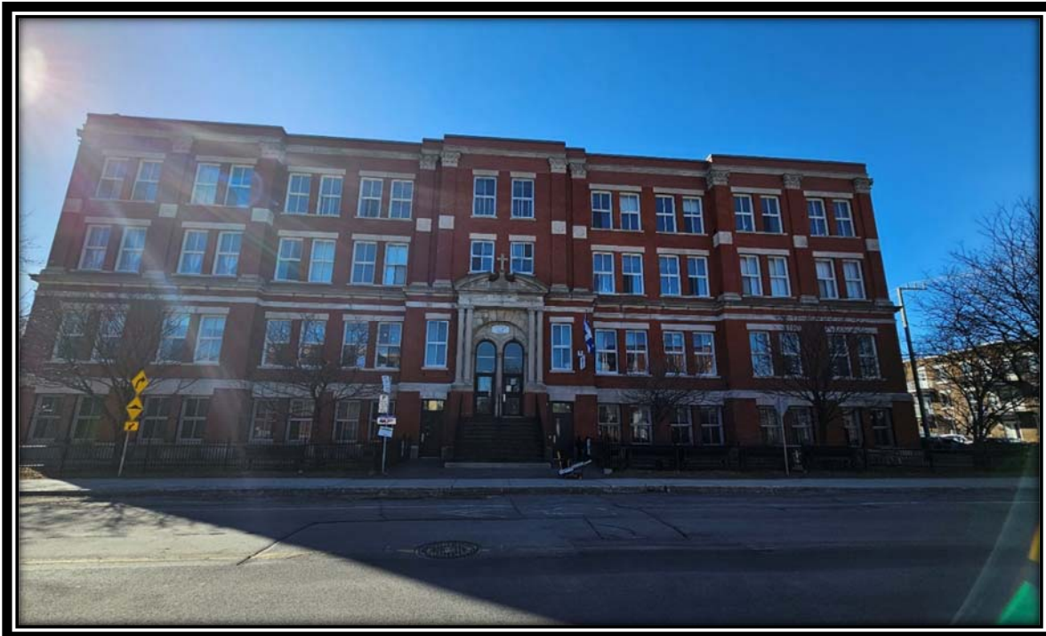
FIGURE 2 : FAÇADE DU BÂTIMENT PRINCIPAL (454, RUE CAISSE, VERDUN)
