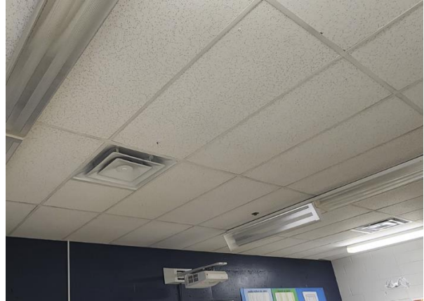
Plafond type d'une classe
