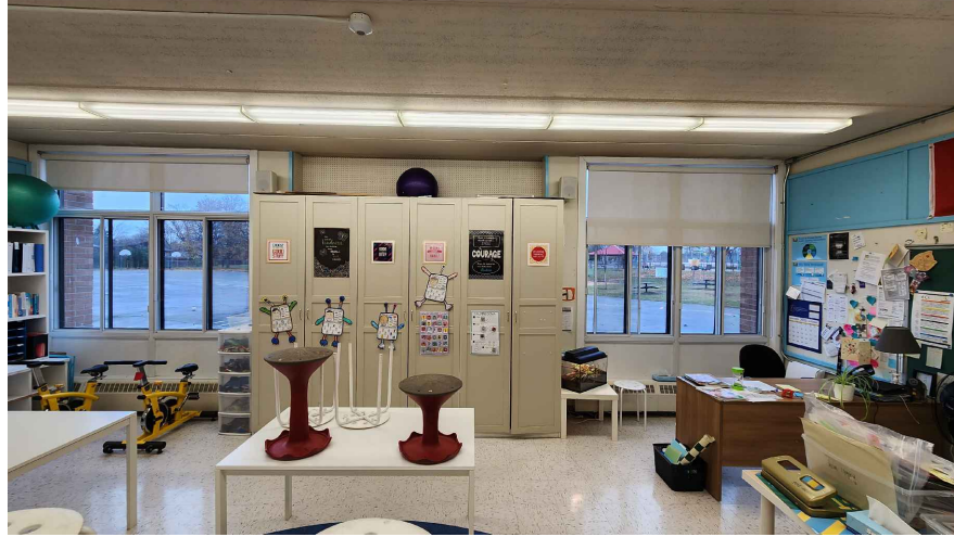
TYPIQUE CABINET DE CHAUFFAGE DANS UNE CLASSE
