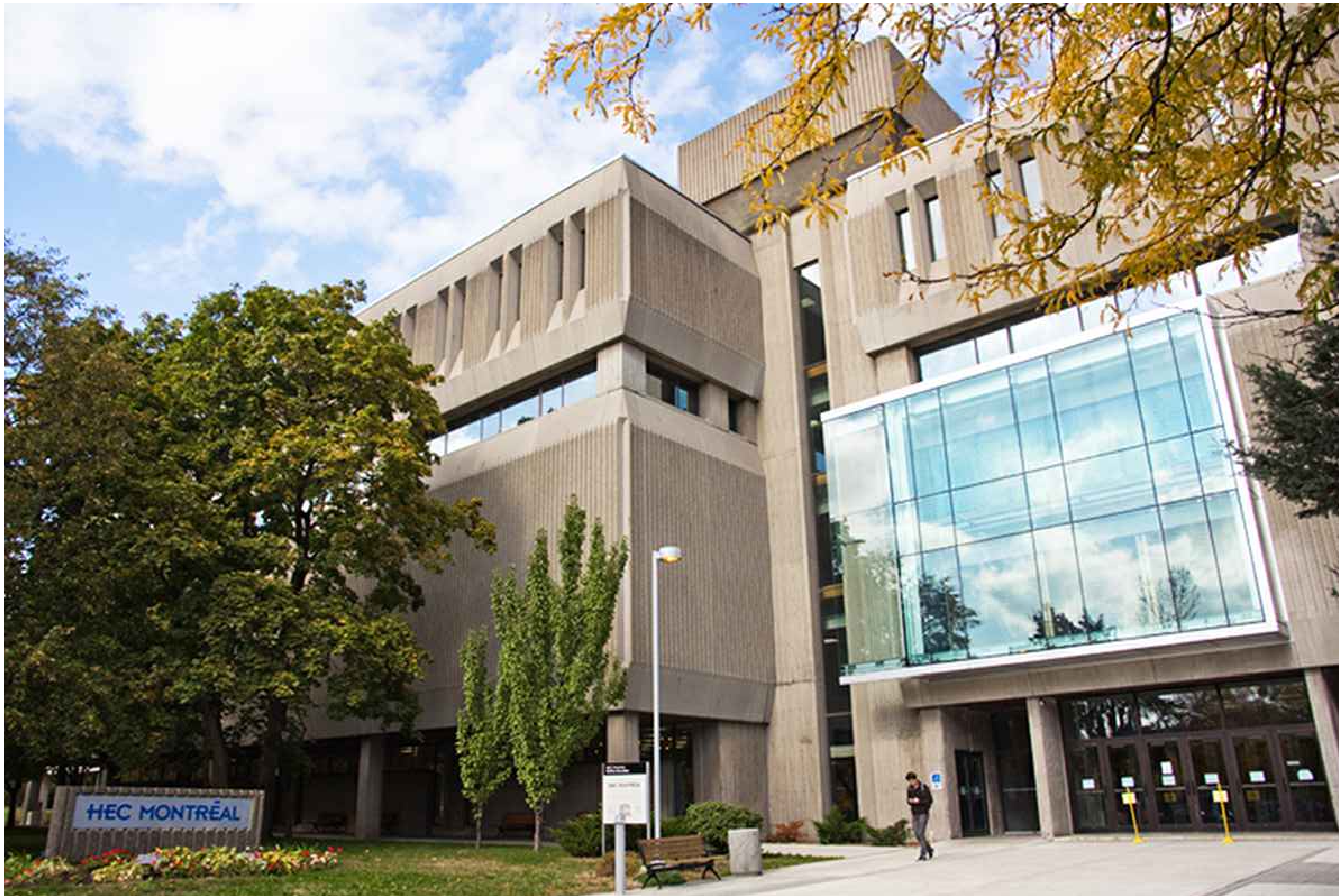
HEC MONTRÉAL - ÉDIFICE DECELLES - RÉNOVATION DU 7e ÉTAGE
