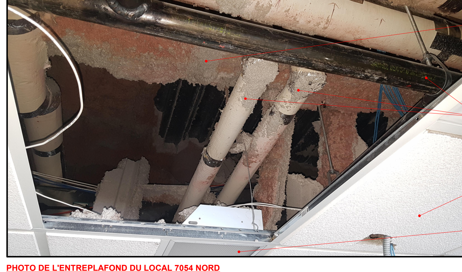
PHOTO DE L'ENTREPLAFOND DU LOCAL 7054 NORD
