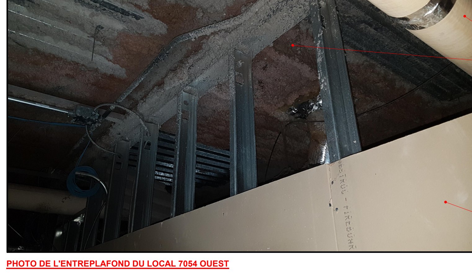
PHOTO DE L'ENTREPLAFOND DU LOCAL 7054 OUEST
