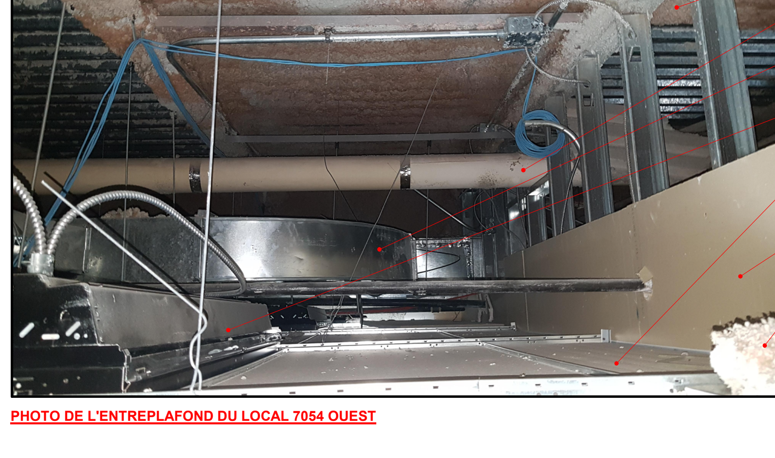
PHOTO DE L'ENTREPLAFOND DU LOCAL 7054 OUEST
