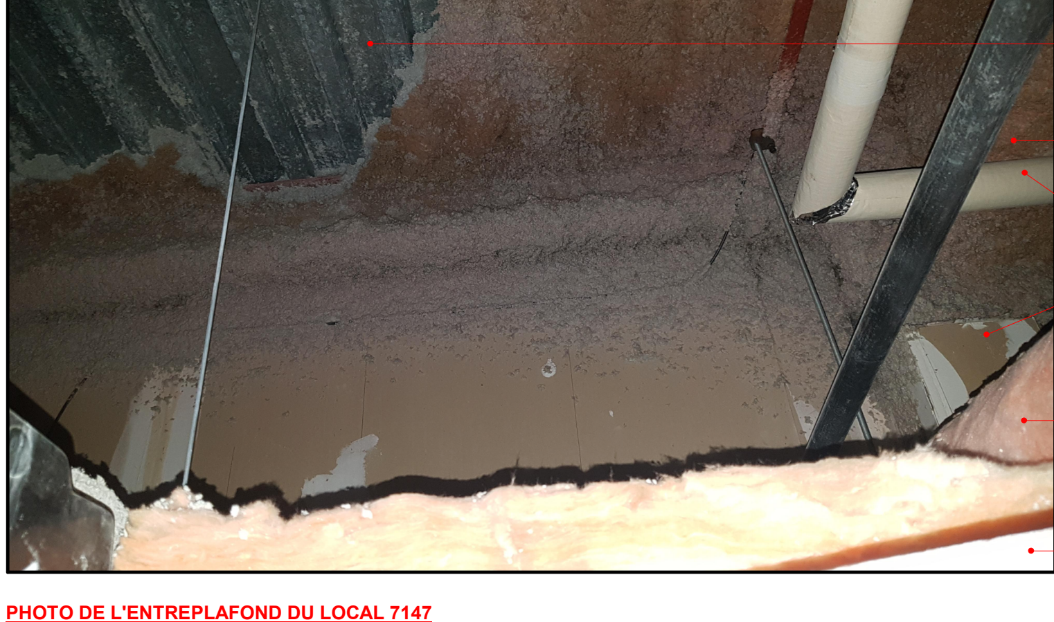
PHOTO DE L'ENTREPLAFOND DU LOCAL 7147
