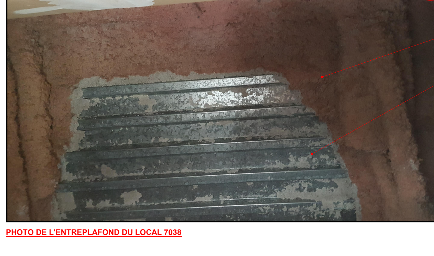
PHOTO DE L'ENTREPLAFOND DU LOCAL 7038
