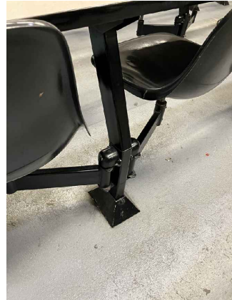
PHOTO 6: SUPPORT EN ACIER EXISTANT SOUS LES SIÈGES À PEINDRE.
