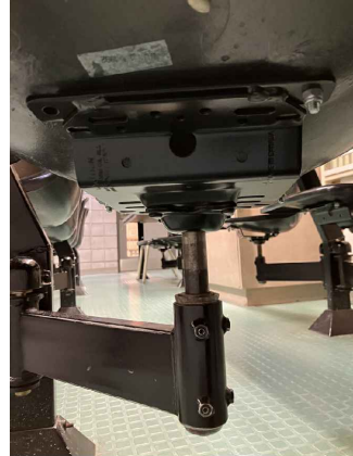
PHOTO 5: NOUVEAU MÉCANISM. NOUVEAU MÉCANISM FOURNIS PAR CLIENT. INTALLATION PAR ENTREPRENEUR.
