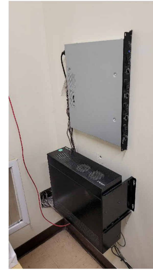
A E300 SYSTÈME INTERCOMMUNICATION À RELOCALISER
