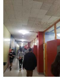
PHOTO 1 - PLAFOND SUSPENDU À REMPLACER CORRIDOR 202
