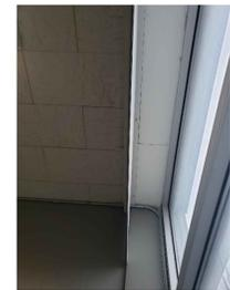
PHOTO 4 - FINITION MÉTALLIQUE À REMPLACER
