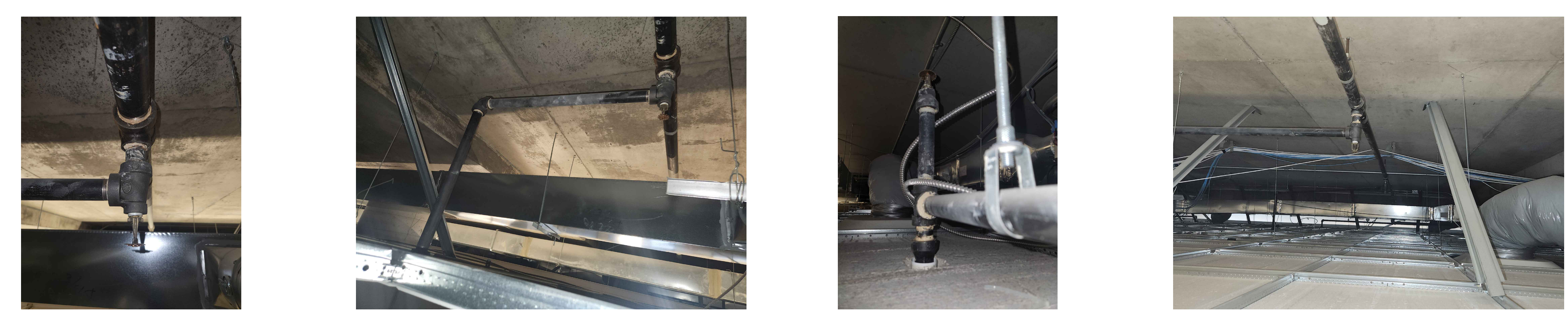
3 PHOTOS TYPIQUES GICLEURS DANS L'ENTREPLAFOND SANS ÉCHELLE
