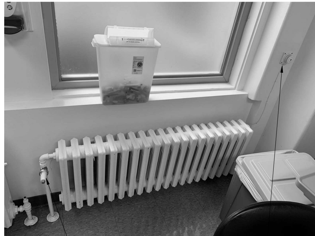
ROBINET MODULANT ET SONDE MURALE A ENLEVER ET TUYAUTÉRIE A MODIFIER. SE RÉFÉRER AU DÉTAIL 3, DU PLAN MX-M-DT01.
