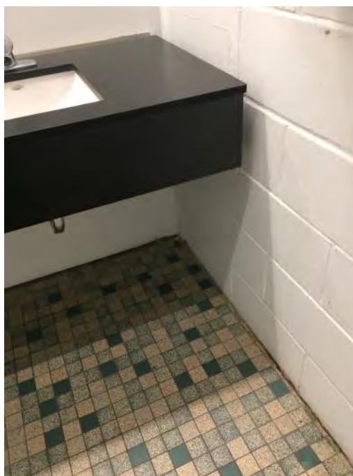
Photo 3 - Composé à joints sur le mur au rez-de-chaussée qui ne contient pas d'amiante, local 265f.
