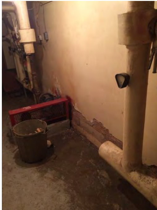
Photo 7 - Plâtre/crépi sur les murs au sous-sol qui ne contient pas d'amiante, local 126b.
