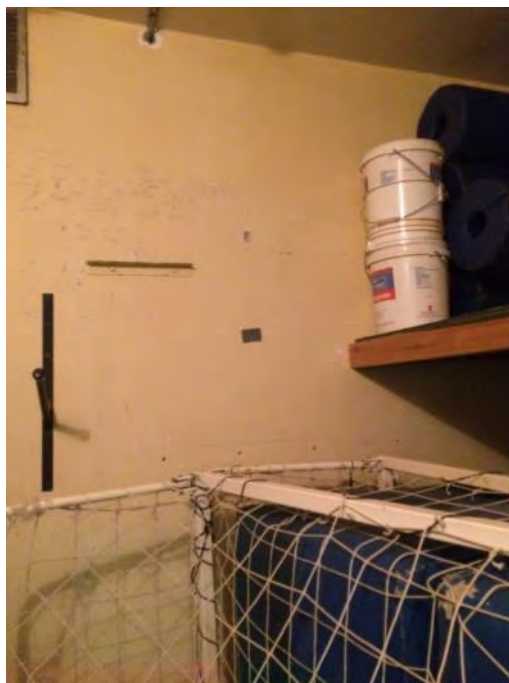
Photo 5 - Plâtre/crépi sur les murs au rez-de-chaussée qui ne contient pas d'amiante, local 253a.
