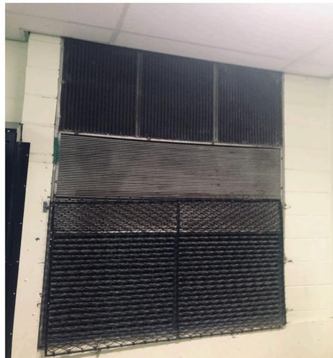
PHOTO 27 – Conduit de ventilation à nettoyer
